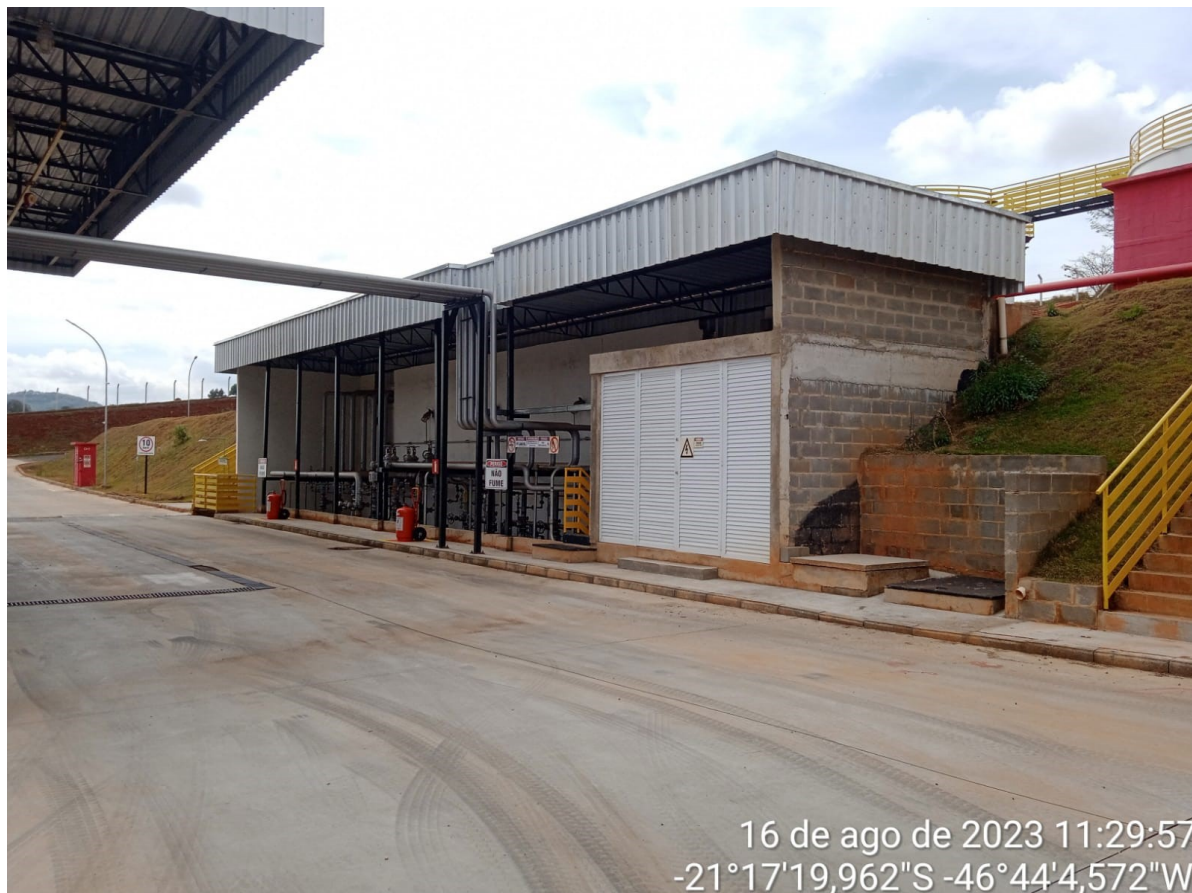
Imagem 5: Casa de bombas de combustível.
