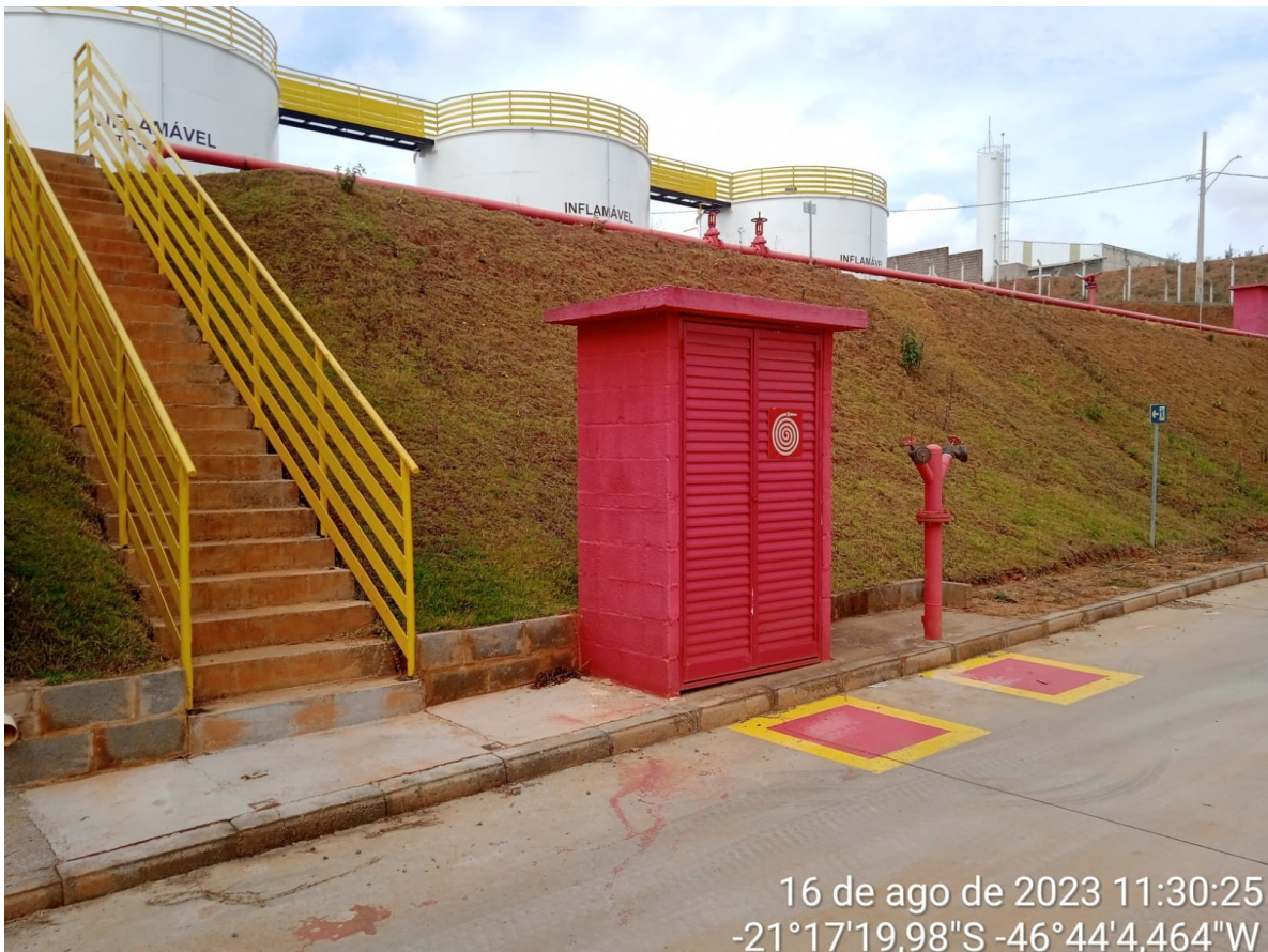
Imagem 8: Escada e abrigo de incêndio em alvenaria e concreto armado.
