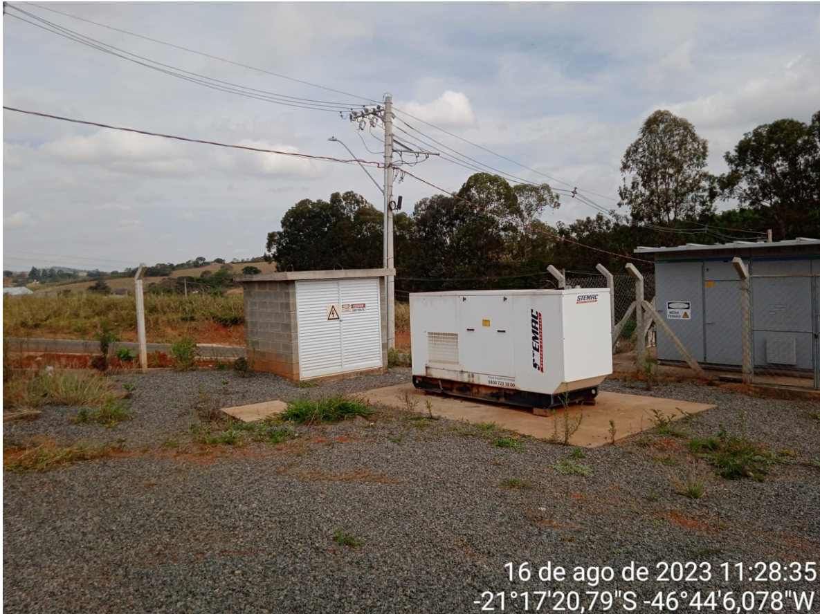
Imagem 7: Casa de alvenaria e concreto armado para gerador.
