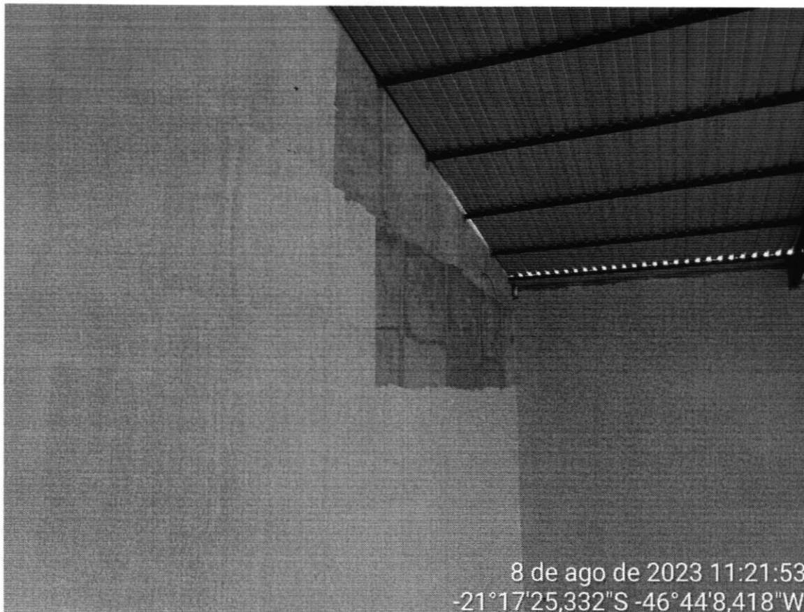
Imagem 21: Aplicação do fundo selador ainda não concluída.
